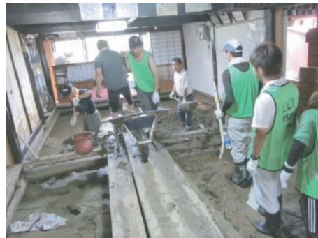
床下の泥出しを手伝う青年ボランティア=八女市
