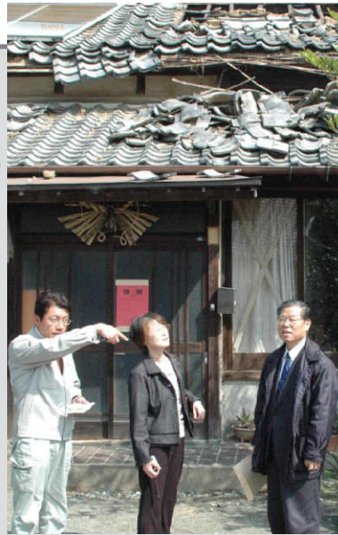
3月29日、志摩町の被害を調査する田村貴昭党九州・沖縄ブロック国政対策委員長(左)
