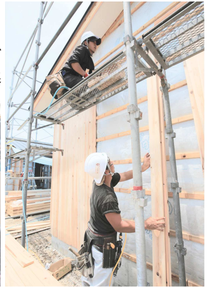
木造仮設住宅づくりに汗を流す熊建労の組合員たち＝熊本県氷川町
